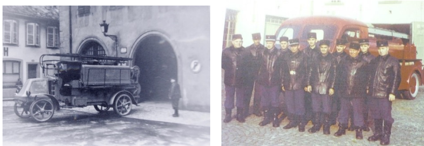
Camions et sapeurs-pompiers volontaires dans les années 1910 (caserne de l'Ancienne douane) et 1950 (Caserne Vieille Île).
